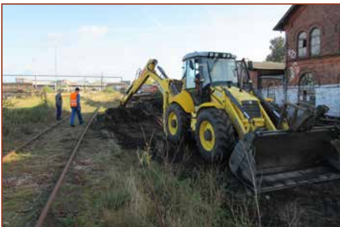
De store maskiner var i brug da de sidste jordarbejder ved remisen blev lavet. Sporet er nu løst fastgjort og skal nu understoppes og lægges i den rigtige højde. Sporet skulle kunne tages i brug inden sommertog næste år.
