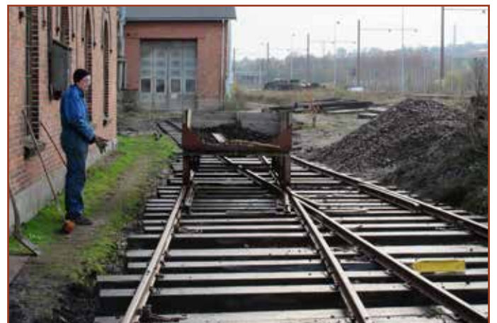
De store maskiner var i brug da de sidste jordarbejder ved remisen blev lavet. Sporet er nu løst fastgjort og skal nu understoppes og lægges i den rigtige højde. Sporet skulle kunne tages i brug inden sommertog næste år.
